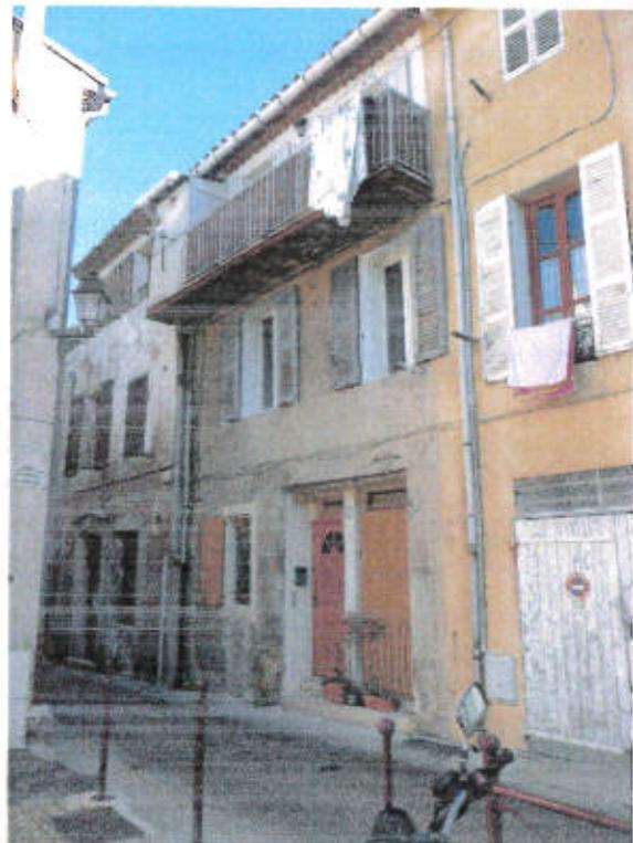
NATURE DE L'ENDUIT : C'est un enduit traditionnel chaulé avec un marquage horizontale et des reprises plus récentes
