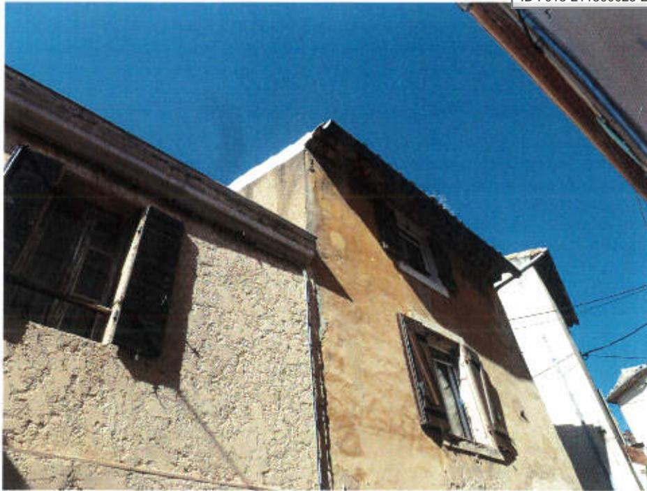
**PRECONISATIONS :** Décroustage de toutes les parties non adhérentes, traiter l'ensemble des fissures et appliquer une passe d'enduit de finition frottassé fin donnant couleur.
