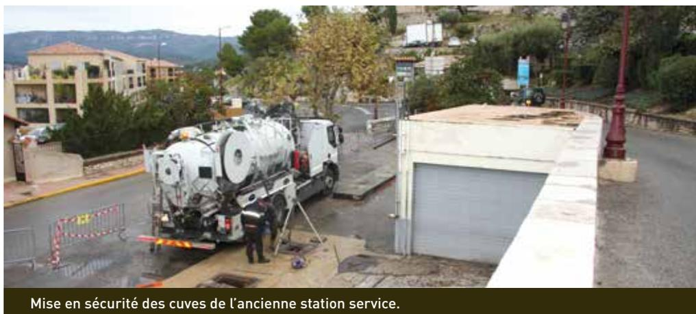
Mise en sécurité des cuves de l'ancienne station service.
