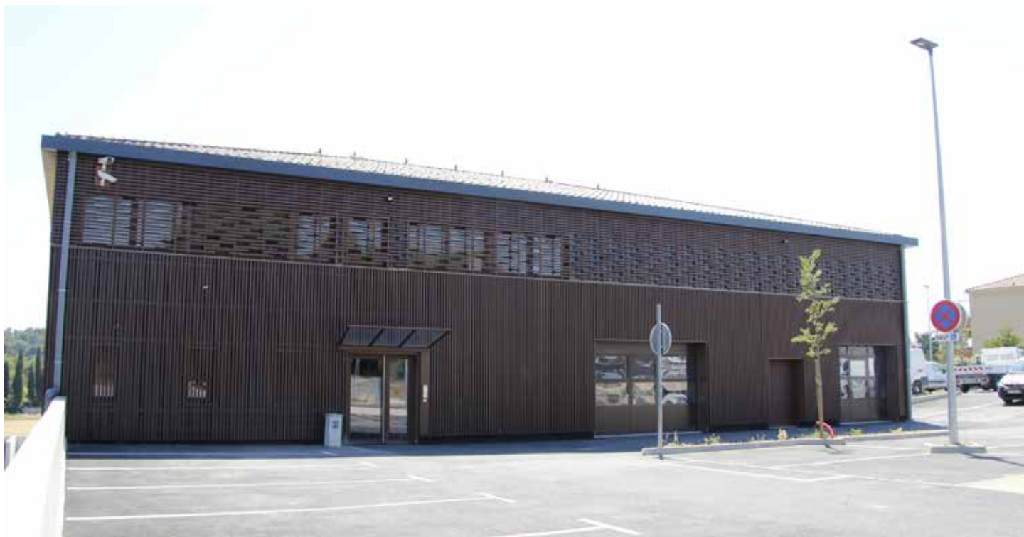
Très moderne, le nouveau bâtiment des régies municipales s'intègre parfaitement dans l'environnement architectural du site.
