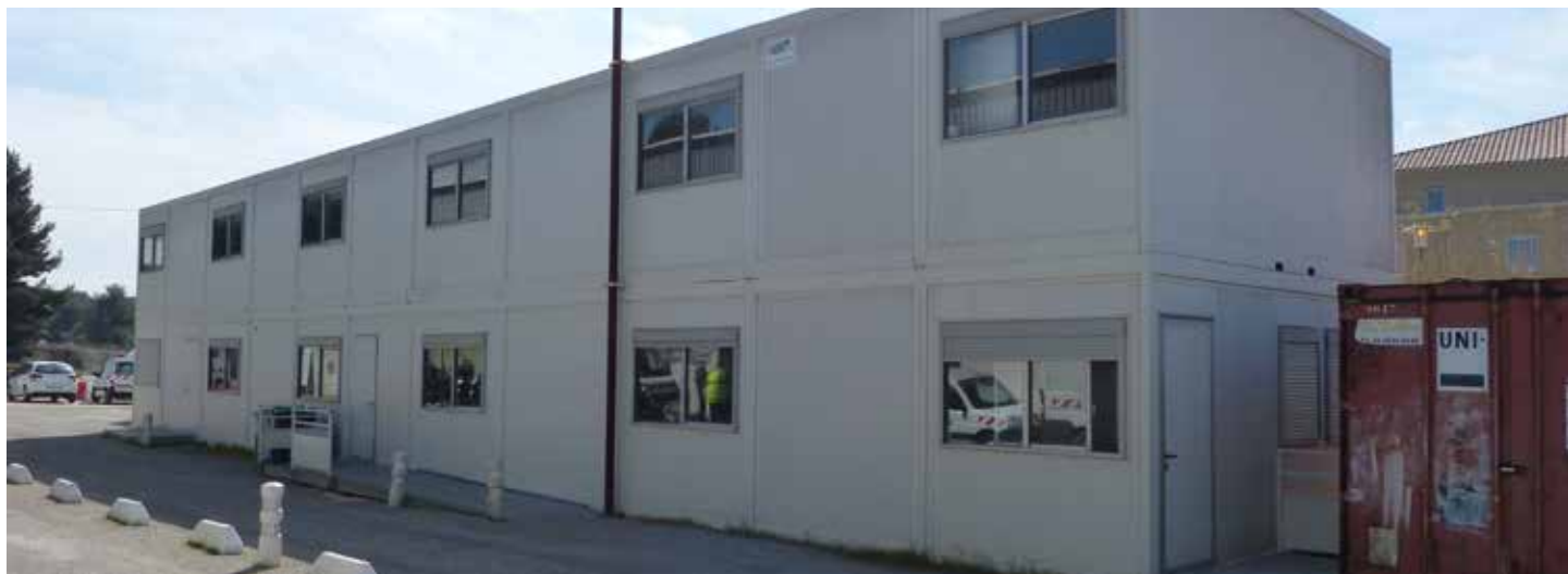
Les bureaux de type modulaire (algeco) et les anciens ateliers avant dépose. Des locaux complètement inadaptés aux conditions de travail des agents et en complète inadéquation avec les habitations environnantes.
