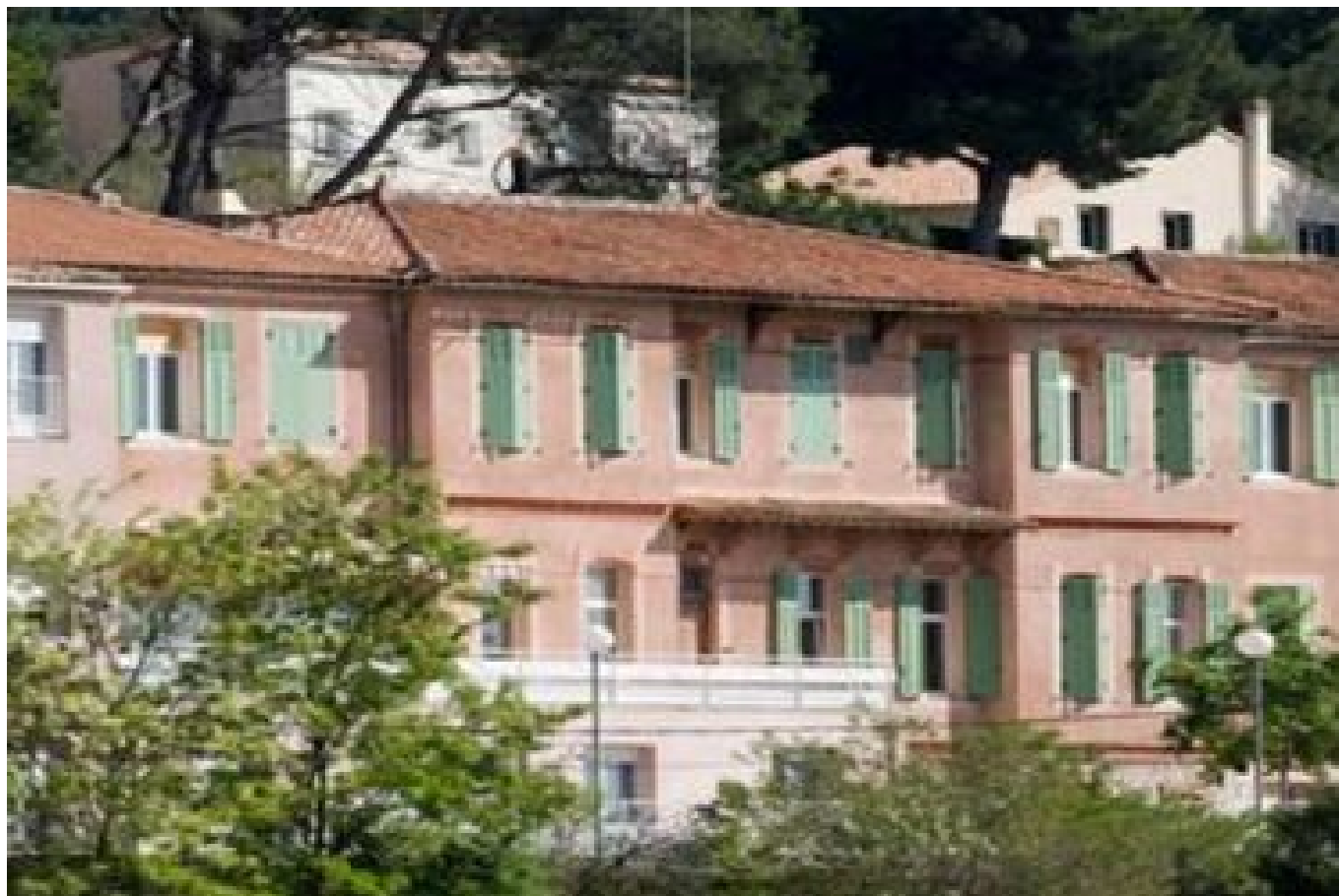
Maison de retraite La Provence
