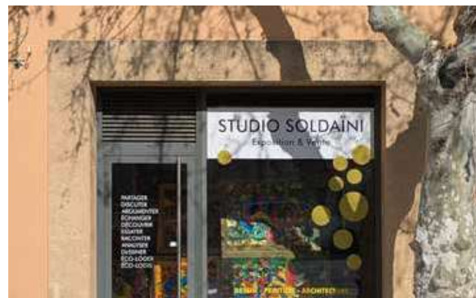
Sur cette devanture en feuillure, le climatiseur est discret, intégré au dessus de la porte.
